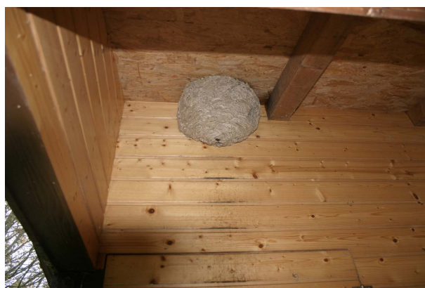
Abb. 3: Nest im überdachten Eingangsbereich des Bienenhauses Büchelberg, 14.11.15 (Foto: G. Reder)
